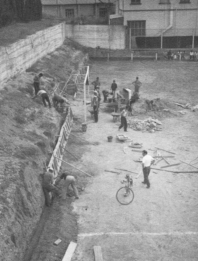
D’esforç i blasfèmies. La ciutadania col·laborant en la col·locació de les tanques del vell camp de La Pineda. L’any 1961. Cedida per Antonio García Abad.
